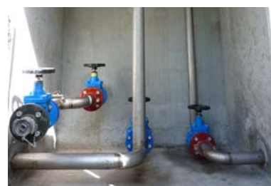
Chambre de vanne de réservoir
