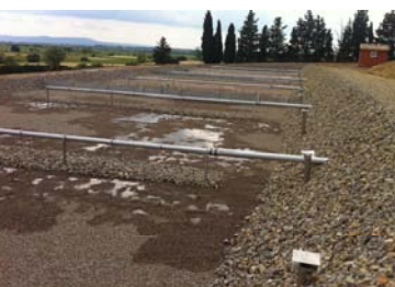
Station d'épuration - filtres plantés
