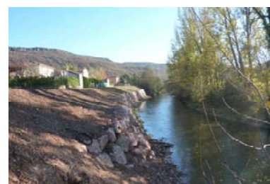
Travaux de confortement - blocs
