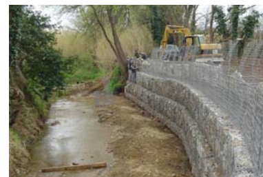
Aménagement hydraulique - gabions
